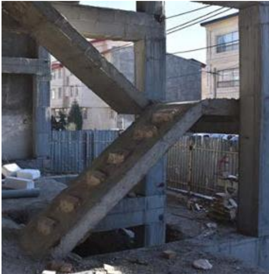
ب: پله بتن ریزی شده
