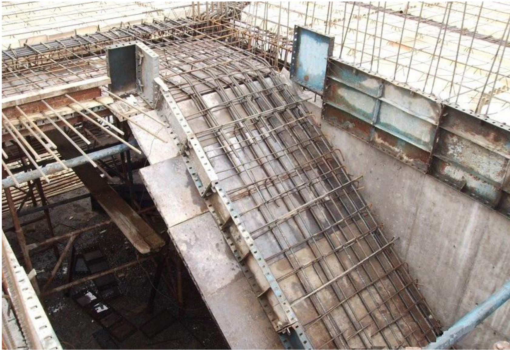
تصویر شماره ۳-۱۴: اجرای سرویس پله با دال بتنی درجا و اتصالات گیردار
