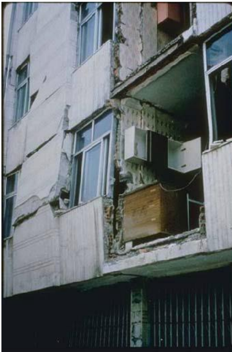
تصویر شماره ۳-۴: تخریب فارج از صفحه دیوارهای بنایی غیر مسلح در زلزله‌های منجیل و بووچ - نشریه ۷۲۹
