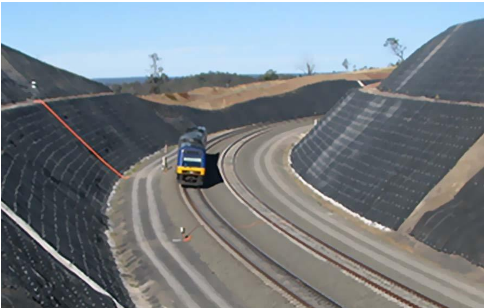
تصویر شماره ۱- ۱۹: نمونه امزای شیب پایدار
