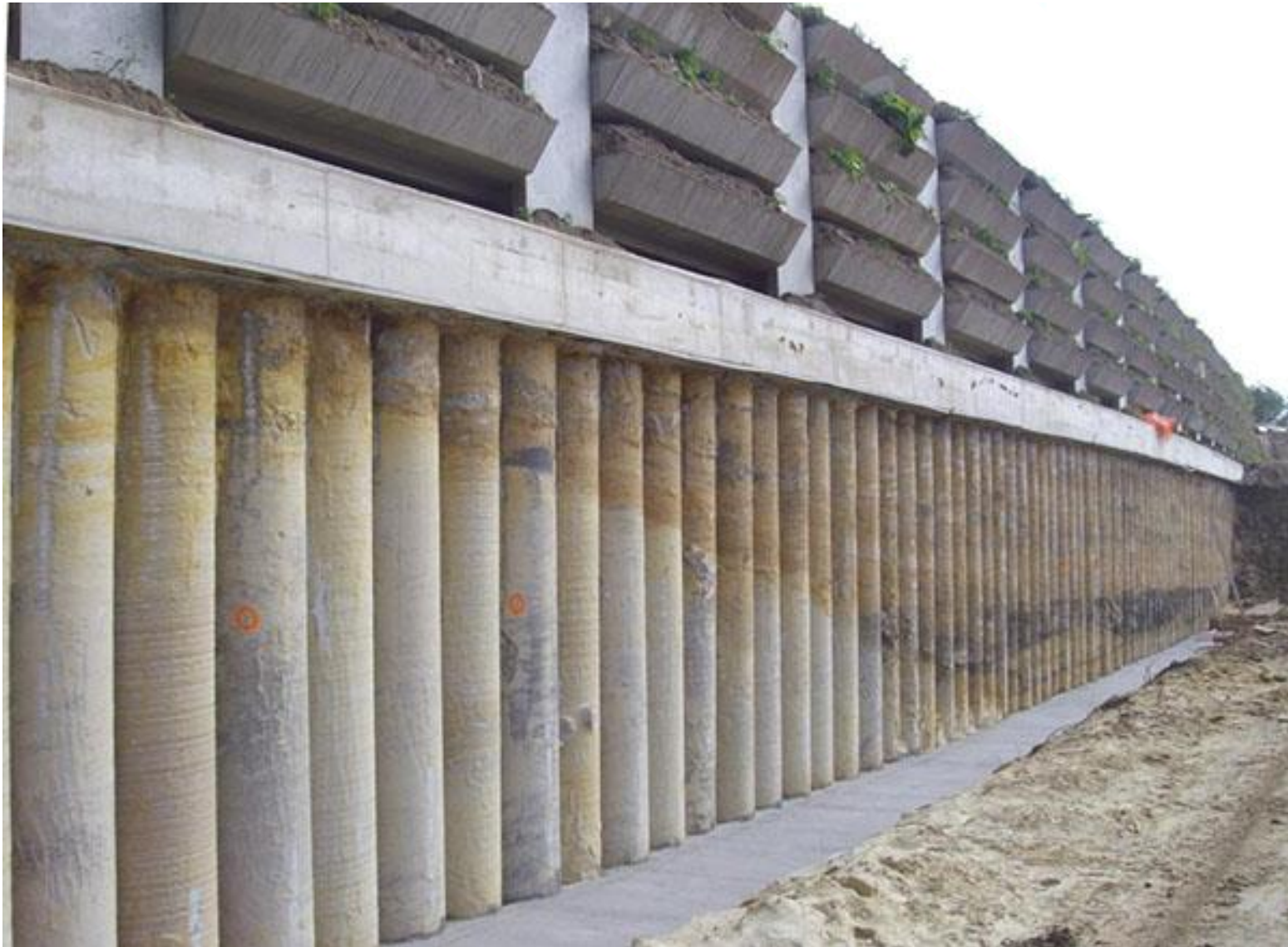
تصویر شماره ۱- ۱۰: نمونه اجرای سازه نگهبان به روش اجرای شمع
