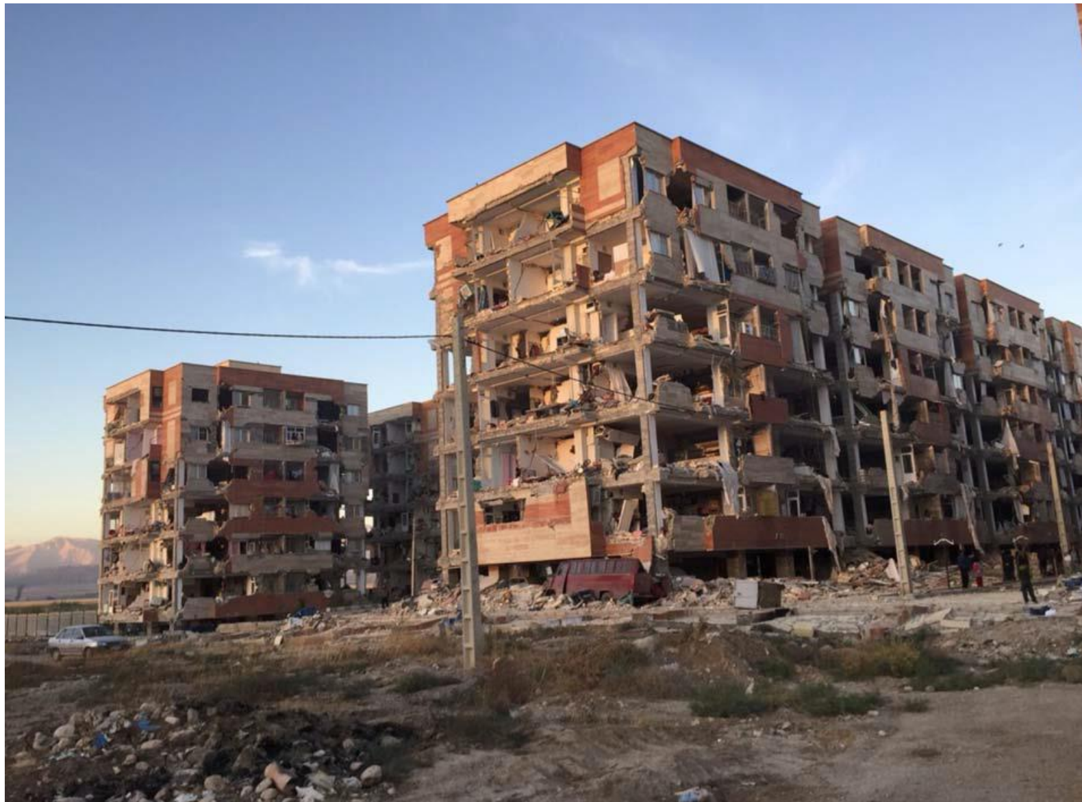
تصویر شماره ۴-۴: تفریب خارج از صفحه دیوارهای بنایی غیر مسلح در زلزله کرمانشاه - سرپل ذهاب - مرکز تحقیقات راه، مسکن و شهرسازی
