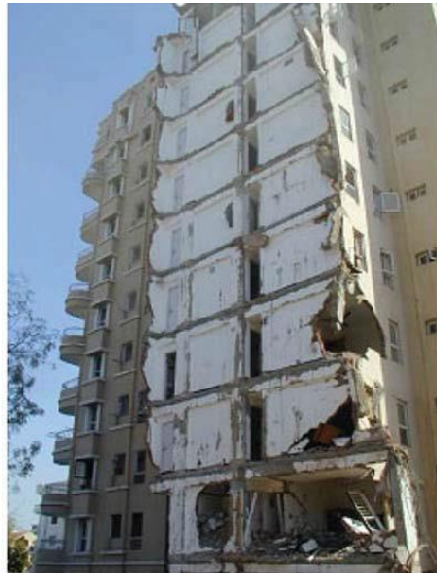
تصویر شماره ۳-۴: تخریب فارج از صفحه دیوارهای بنایی غیر مسلح در زلزله‌های منجیل و بووچ - نشریه ۷۲۹
