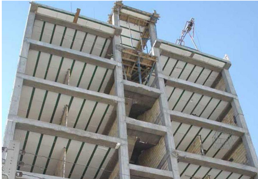
تصویر شماره ۳-۸: تشکیل ستون کوتاه در ستون‌های کنار
