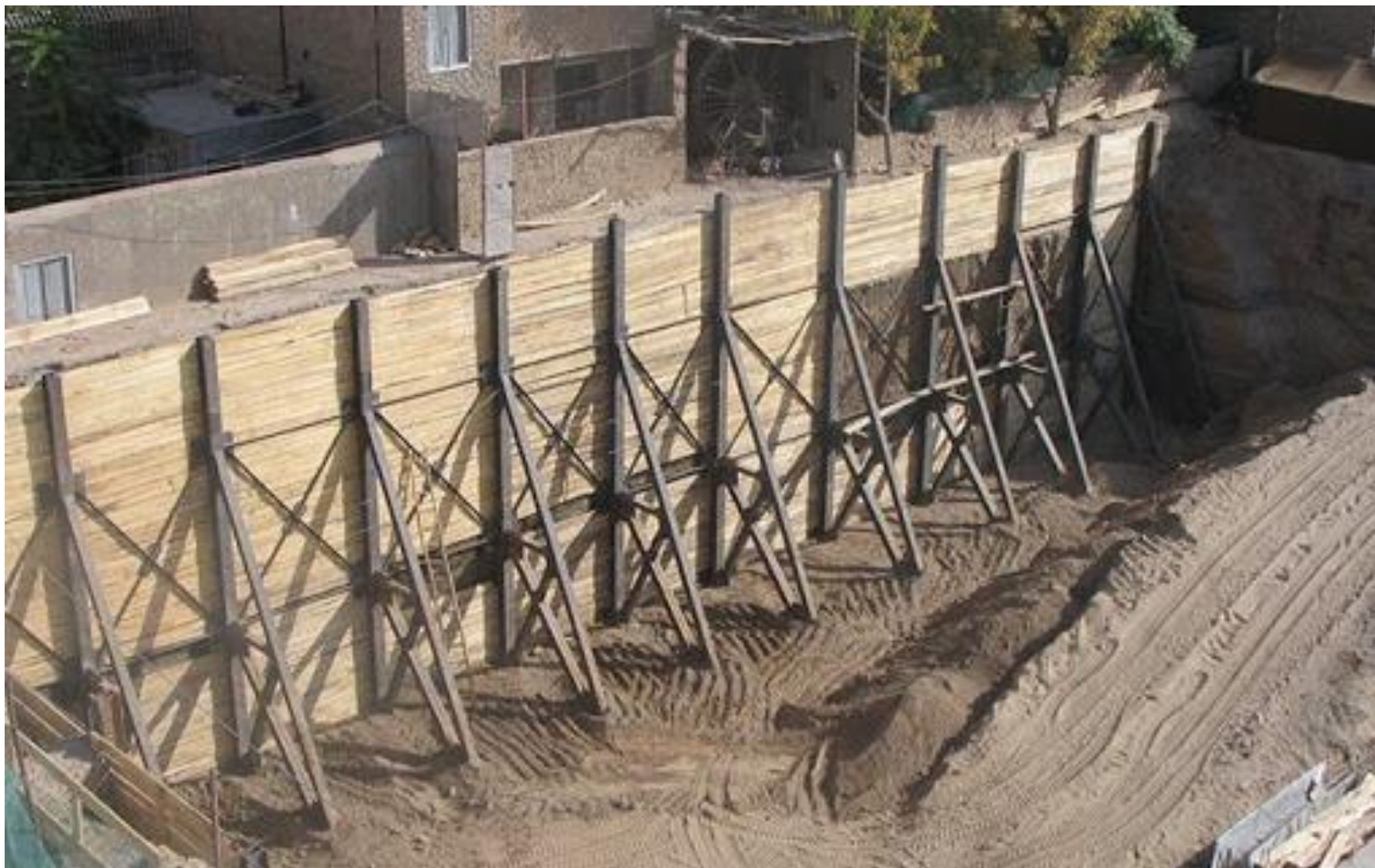
تصویر شماره ۱- ۱۳- الف: اجرای سازه نگهبان به روش فرپایی (مهافاک با تفتہ‌گذاری)
