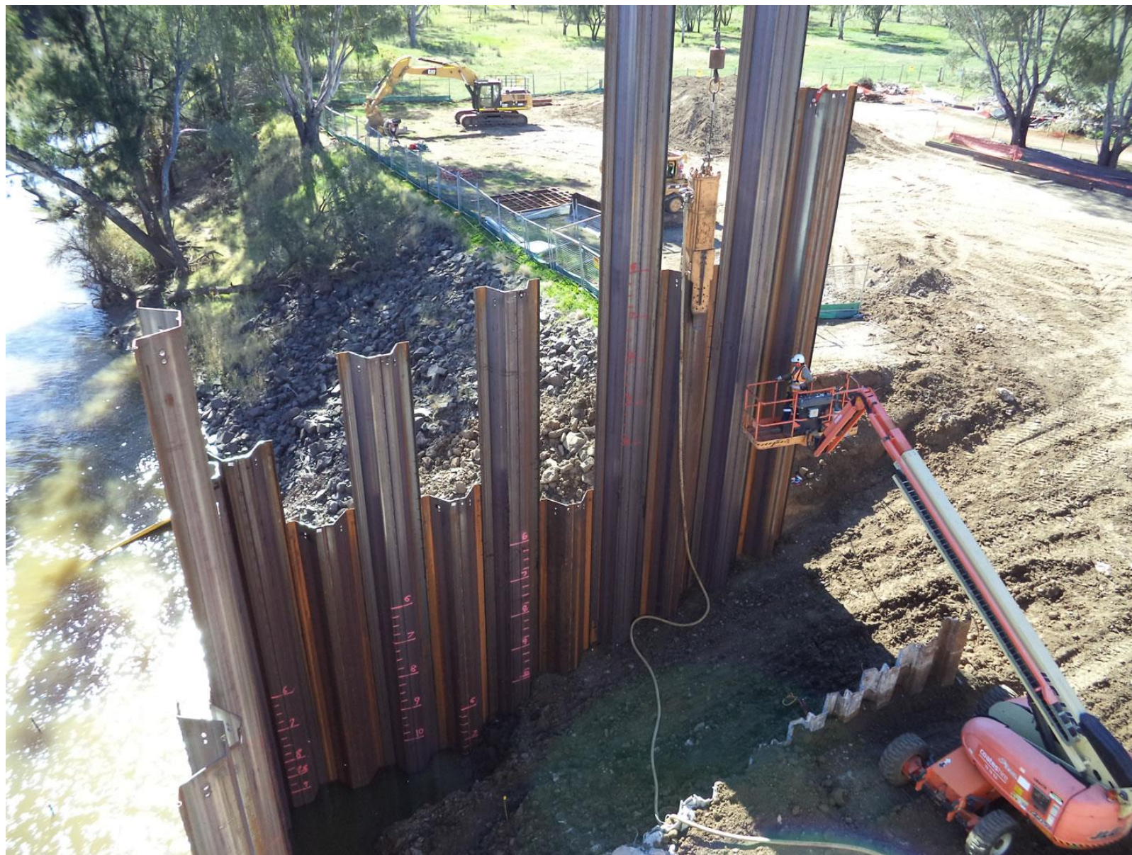
تصویر شماره ۱- ۱۲: اجرای سازه نگهبان به روش سپرکوبی
