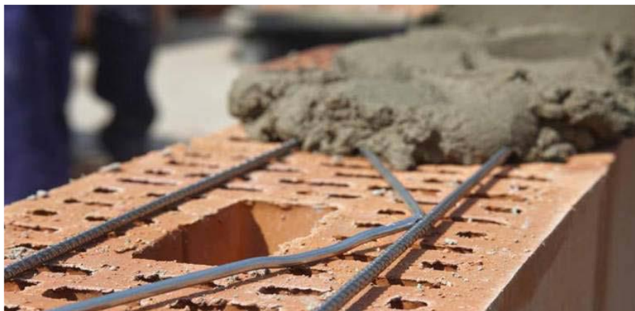
شکل ن ۷۲۹: ۳-۱: میلگرد بستر فرپایی قبل از پفش کردن ملات
