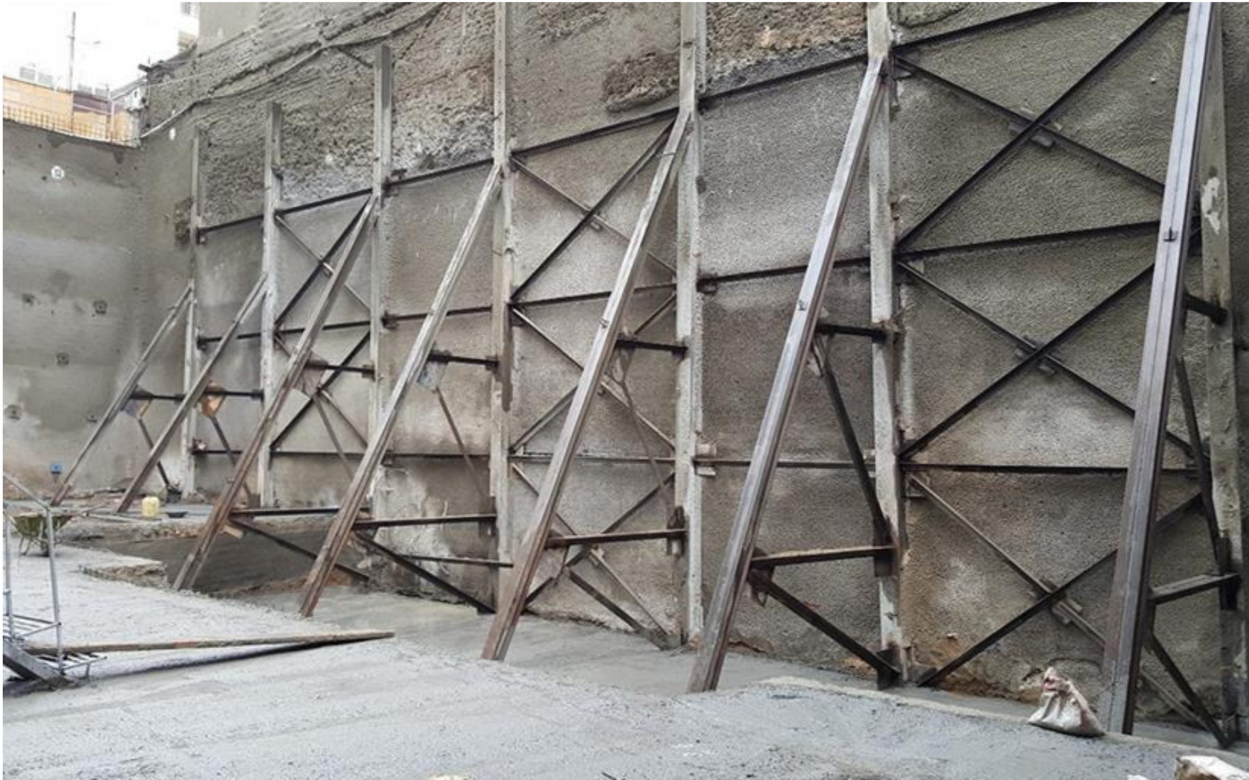
تصویر شماره ۱- ۱۳-ب: اجرای سازه نگهدارنده (روش فرپایی (مهارشاک با شبکه مش و شاتکریت)
