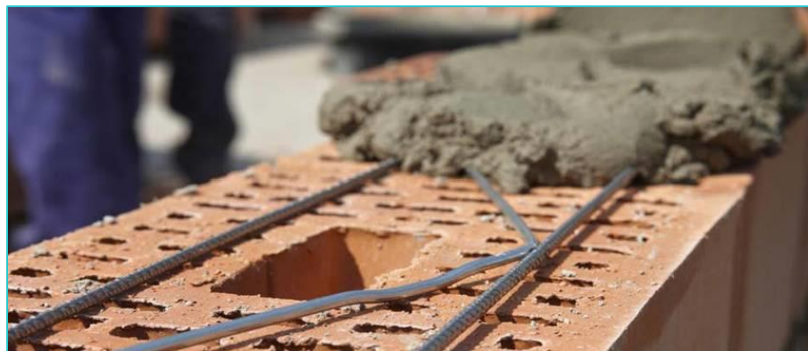
نحوه تعبیه میلگردهای ناحیه یک سوم میانی ارتفاع دیوار (h) و اتصال به کلاف قائم
